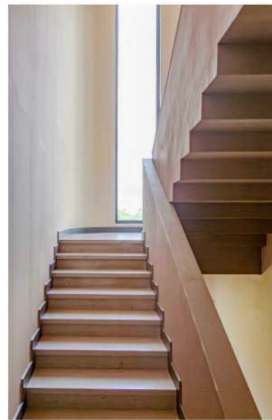
Conçu en travertin, l'escalier d'origine est baigné de lumière naturelle grâce à la grande fenêtre meurtrière.© GroupePatriceBesse
